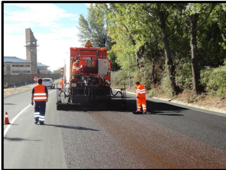
Se emplea en tratamientos superficiales de muy pequeño espesor (habitualmente no superior al centímetro) aportando al pavimento existente una mejora en la impermeabilidad y en las características superficiales (textura superficial y resistencia al deslizamiento).
