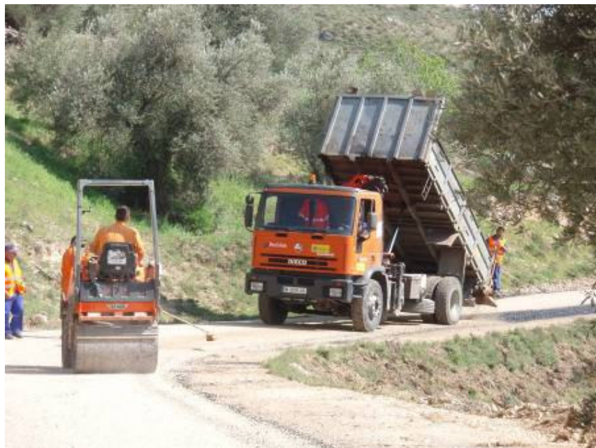
Camión con gravilladora y rodillo compactador.
