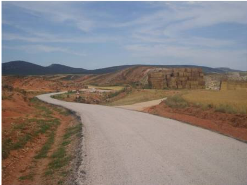
Ejemplo de doble tratamiento superficial recién ejecutado. Carretera local de Almazul a La Quiñorera (Soria)
