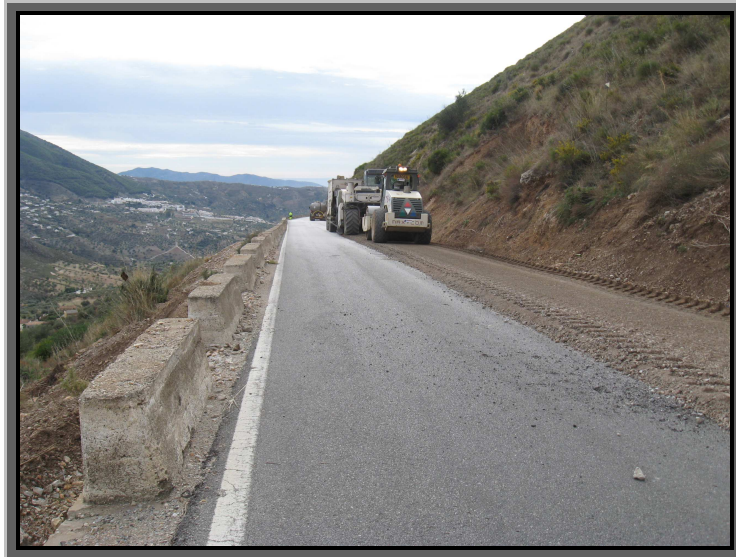
Ctra. Zafarraya a Puente de Don Manuel (Málaga)
