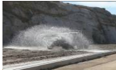
Riego de curado con agua
