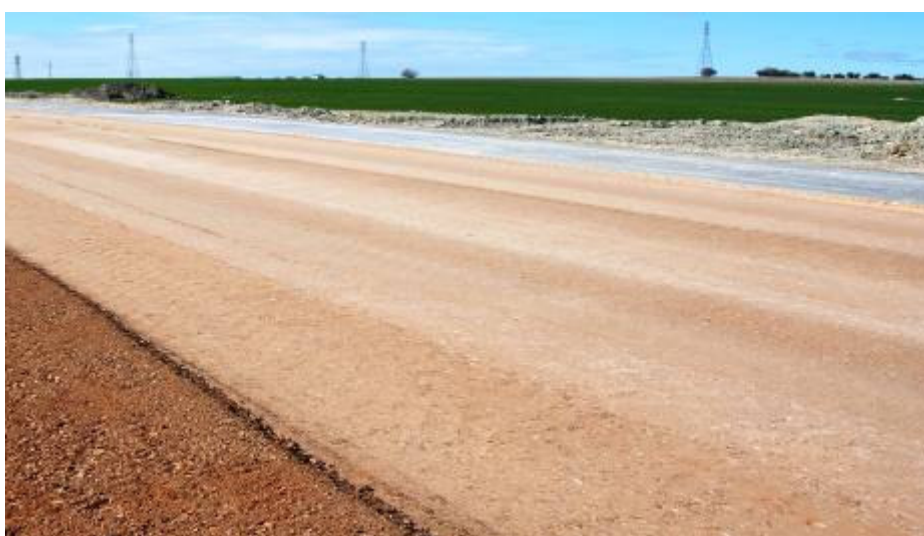
Suelo cemento in situ — Variante de Valdemoro (Madrid)
