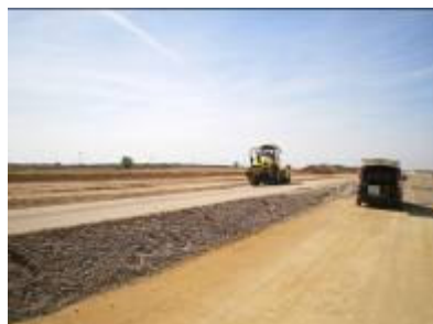
Extendido de material para suelo cemento in situ
