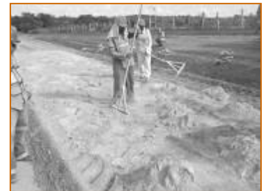
Extendido de cemento en sacos
