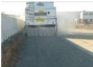
Extendido de cemento
