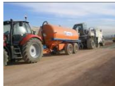
Control de humedad
