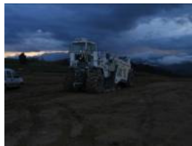
Paralización de equipos por lluvia
